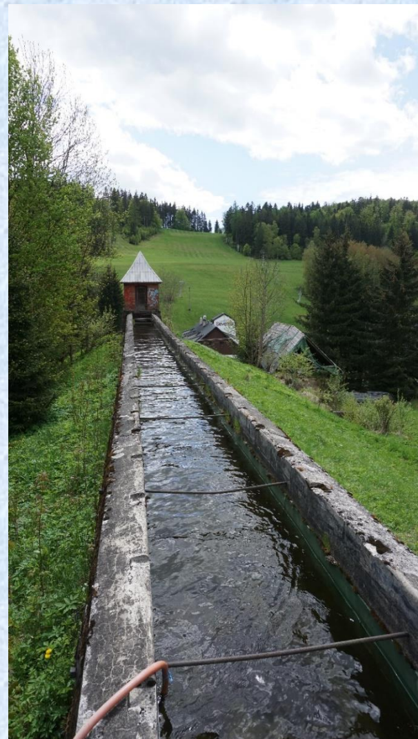
Betonové koryto ke kašně vodní elektrárny v bývalé Anenské huti Foto Radek Bachan, 2021
