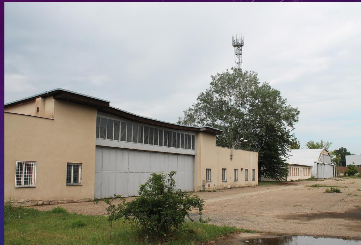
Zachovalé letištní budovy bývalého letiště Brno Černošice.
